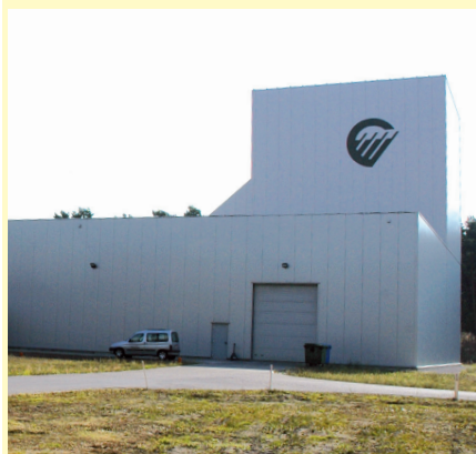
Buitenaanzicht tweede schacht
